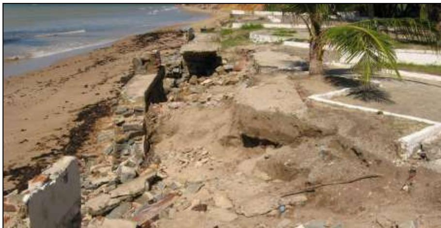
**FIGURA 99:** Praça de Iemanjá com parte de sua estrutura danificada pela constante erosão marinha. **Foto:** Williams Guimarães
