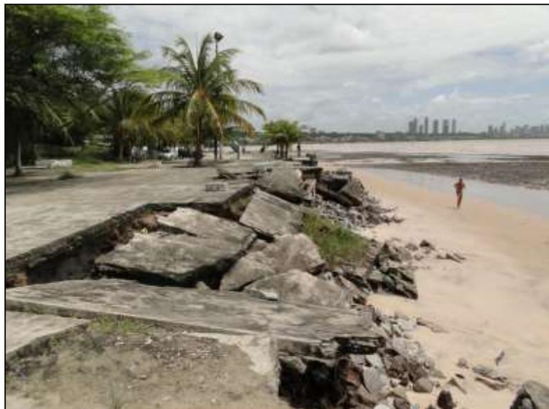
**FIGURA 07:** Estrutura da Praça de Iemanjá danificada pela erosão marinha. **Foto:** Williams Guimarães.
