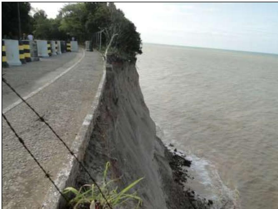
**FIGURA 14:** Comprometimento da rodovia inativa, ocasionado pela erosão localizada no topo da falésia, próxima ao Farol do Cabo Branco. **Foto:** Williams Guimarães
