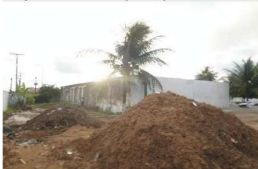
Figura 122 - Centro de Reservação R-7 (Apoiados – 2 x 2.000 m³)
