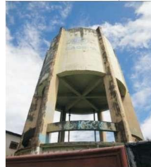
Figura 149 - Reservatório Elevado R-27 (Elevado – 200 m³)
