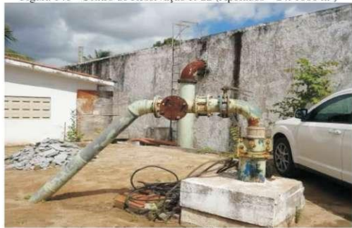
Figura 146 - Centro de Reservação R-22 (Apoiados – 2 x 1000 m³)
