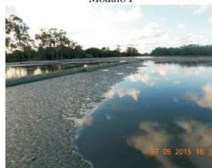
Figura 190 - Lagoa Anaeróbia 01 do Módulo I
