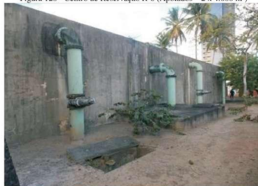
Figura 120 - Centro de Reservação R-6 (Apoiados – 2 x 4.000 m³)
