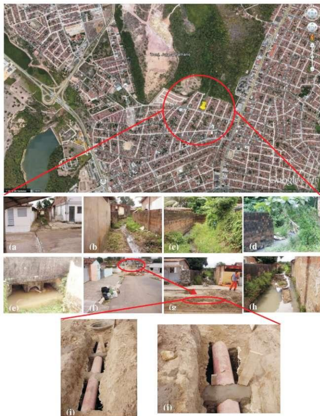
Figura 280 - Área com problema de micro e macrodrenagem no Bairro dos Novais, João Pessoa, PB: adensamento populacional em área de drenagem natural de cursos de água (a, b, c, d, e, f, g, h) e falta de manutenção e obstrução parcial da galeria dos sistemas de micr e macrodrenagem para instalação de um duto de esgotamento sanitário (e, f, g, h, i, j).
