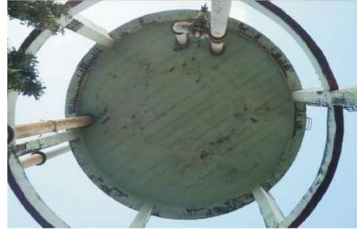
Figura 148 - Reservatório Elevado R-23 (Elevado – 100 m³)
