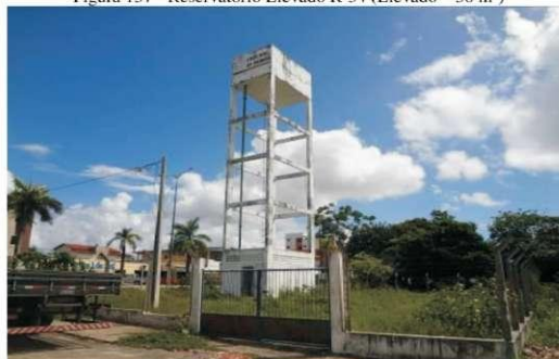
Figura 157 - Reservatório Elevado R-34 (Elevado – 50 m³)
