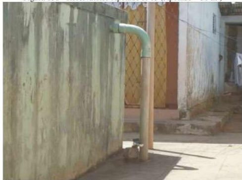
Figura 138 - Reservatório Apoiado R-15 (Apoiado – 50 m³)
