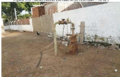
Figura 152 - Reservatório Elevado R-28 (Elevado – 50 m³)
