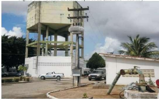
Figura 145 - Centro de Reservação R-22 (Elevado – 700 m³)
