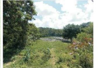
Figura 209 - Emissário de recalque da EEE Valentina II.
