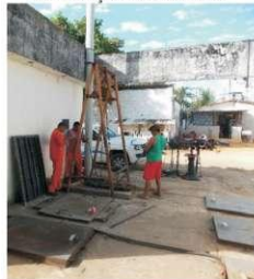
Figura 226 - Equipe de manutenção da CAGEPA
