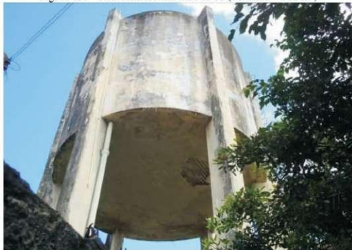
Figura 139 - Reservatório Elevado R-16 (Elevado – 100 m³)
