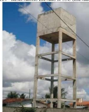
Figura 164 - Reservatório Elevado R-35C (Elevado – 50 m³)
