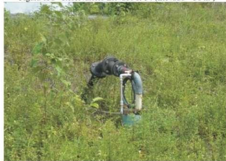
Figura 158 - Reservatório Elevado R-34 (Elevado – 50 m³)
