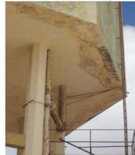
Figura 128 - Reservatório Elevado R-10 (Elevado – 700 m³)
