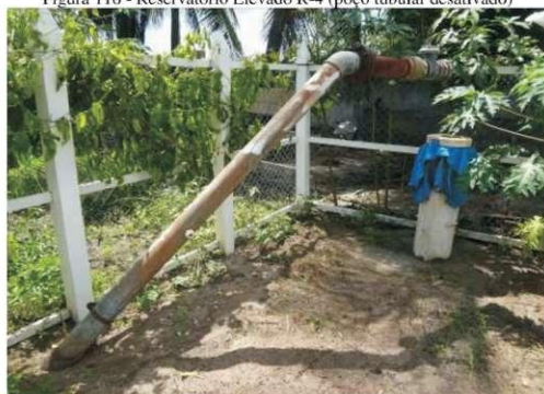
Figura 116 - Reservatório Elevado R-4 (poço tubular desativado)
