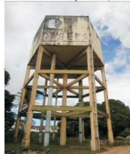
Figura 143 - Centro de Reservação R-21 (Elevado – 700 m³)
