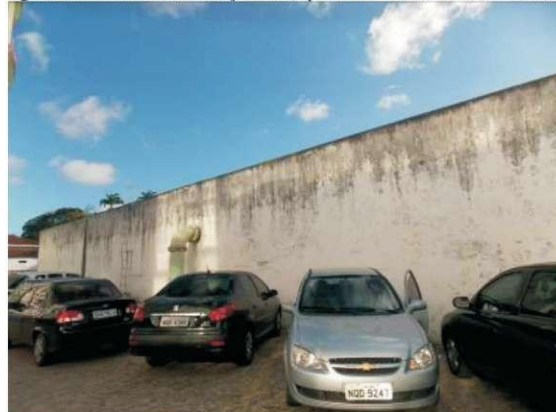
Figura 110 - Centro de Reservação R-1 (Apoiados – 2 x 2.000 + 1 x 1.000 m³)
