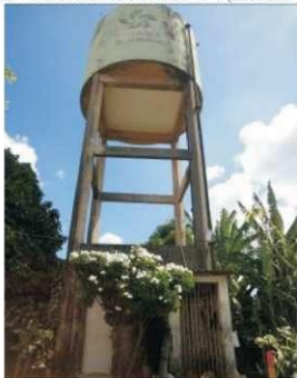
Figura 115 - Reservatório Elevado R-4 (Elevado – 100 m³)
