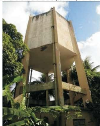
Figura 135 - Centro de Reservação R-14 (Elevado – 200 m³)
