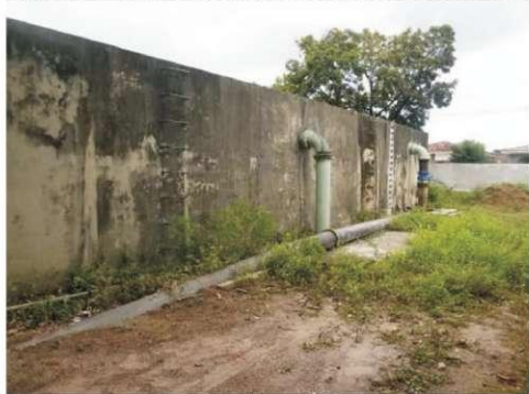
Figura 130 - Centro de Reservação R-11 (Apoiados – 2 x 1000 m³)
