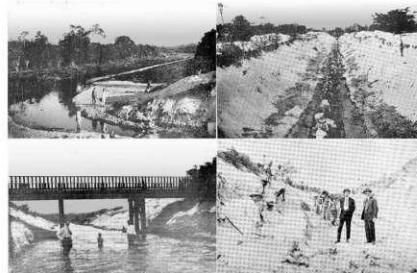
Figura 41 - Fotografias das obras de saneamento do Rio Jaguaribe
