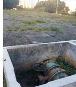
Figura 126 - Centro de Reservação R-9 (Apoiados – 2 x 1000 m³)
