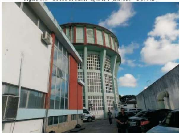
Figura 109 - Centro de Reservação R-1 (Elevado – 2.000 m³)
