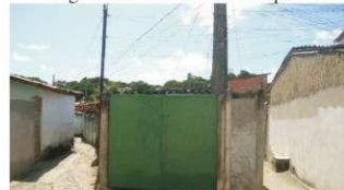
Figura 228 - EEE Bairro dos Ipês 1
