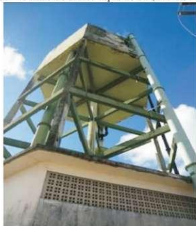
Figura 153 - Centro de Reservação R-29 (Elevado – 500 m³)
