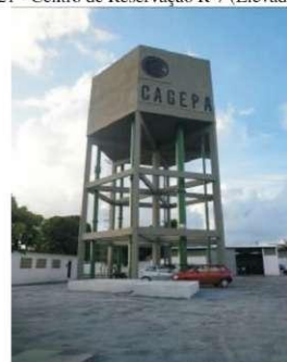
Figura 121 - Centro de Reservação R-7 (Elevado – 700 m³)
