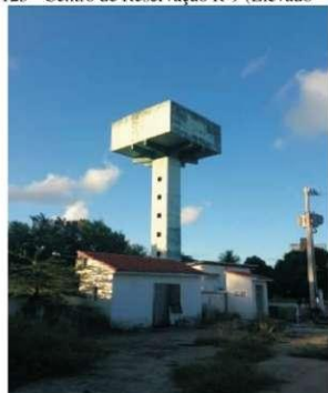
Figura 125 - Centro de Reservação R-9 (Elevado – 600 m³)
