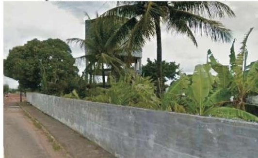
Figura 114 - Reservatório Elevado R-3 (Elevado – 600 m³)
