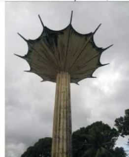
Figura 129 - Centro de Reservação R-11 (Elevado – 600 m³)
