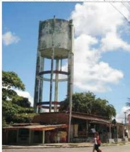
Figura 147 - Reservatório Elevado R-23 (Elevado – 100 m³)
