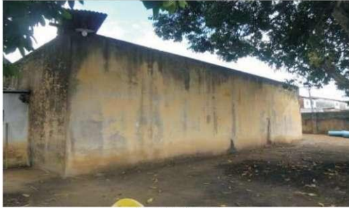
Figura 144 - Centro de Reservação R-21 (Apoiados – 2 x 1000 m³)
