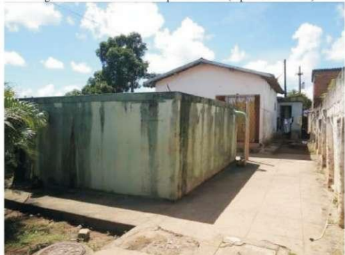
Figura 137 - Reservatório Apoiado R-15 (Apoiado – 50 m³)
