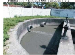
Figura 171 - Entrada dos Tanques 1 e 2
