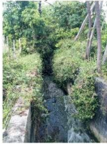
Figura 198 - Canal do Efluente Tratado dos Módulos I e II próximo ao Rio Cuiá
