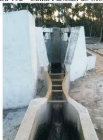
Figura 192 - Calha Parshall do Módulo I
