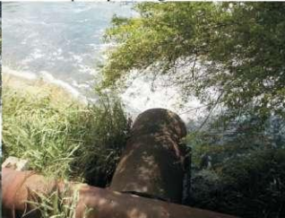
Figura 186 - Tubulação de Entrada construída devido à obstrução da entrada principal (Imagem 02)
