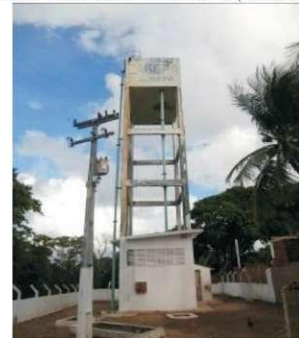
Figura 151 - Reservatório Elevado R-28 (Elevado – 50 m³)
