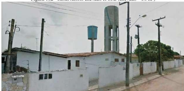
Figura 162 - Reservatório Elevado R-35B (Elevado – 50 m³)
