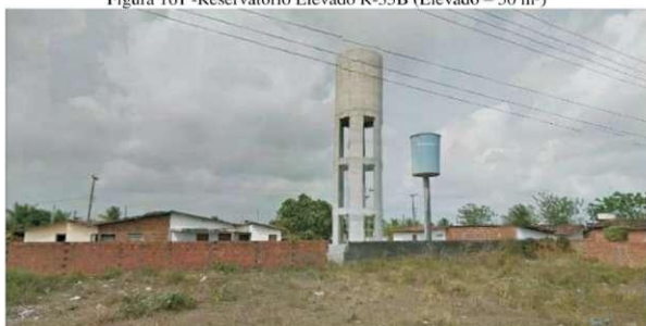
Figura 161 - Reservatório Elevado R-35B (Elevado – 50 m³)
