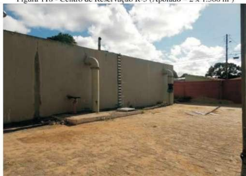
Figura 118 - Centro de Reservação R-5 (Apoiado – 2 x 1.500 m³)
