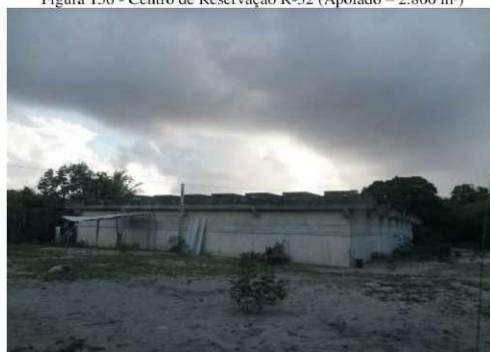
Figura 156 - Centro de Reservação R-32 (Apoiado – 2.800 m³)
