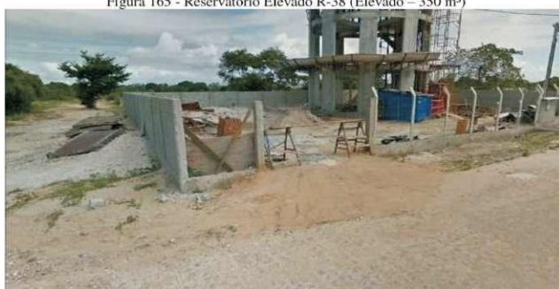
Figura 165 - Reservatório Elevado R-38 (Elevado – 350 m³)
