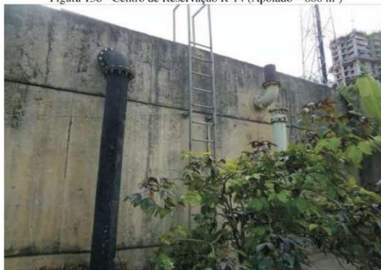
Figura 136 - Centro de Reservação R-14 (Apoiado – 600 m³)
