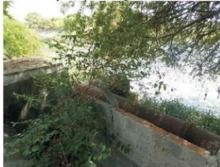
Figura 185 - Tubulação de Entrada construída devido à obstrução da entrada principal (Imagem 01)
