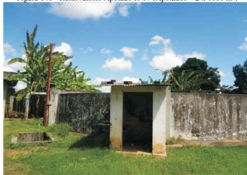
Figura 141 - Reservatório Apoiado R-17 (Apoiados – 2 x 1000 m³)
