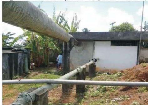
Figura 142 - Reservatório Apoiado R-17 (Apoiados – 2 x 1000 m³)
