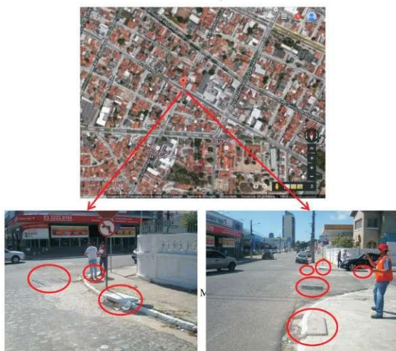
Figura 276 - Problemas de alagamentos no cruzamento da Av. Pedro II com a Av. Coremas, Centro, João Pessoa, apesar da existência de microdrenagem, em destaque.
