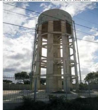
Figura 166 - Reservatório Elevado R-38 (Elevado – 350 m³)
