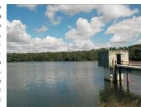
Figura 85 - Barragem de Marés - Torre de Tomada d'água
