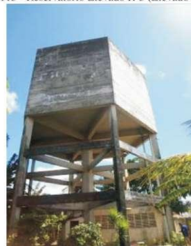
Figura 113 - Reservatório Elevado R-3 (Elevado – 600 m³)
