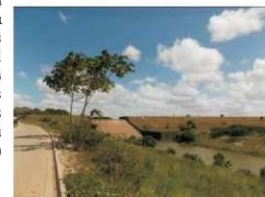
Figura 86 - Barragem Gramame/Mamuaba – Vista do Sangradouro na barragem Gramame
