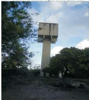
Figura 155 - Centro de Reservação R-32 (Elevado – 200 m³)
