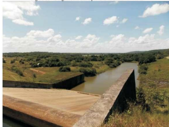
Figura 89 - Sangradouro dos açudes Gramame/Mamuaba
