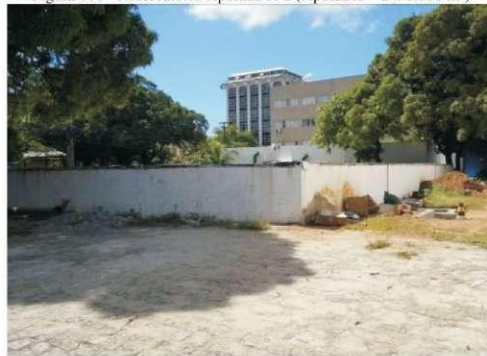
Figura 111 - Reservatório Apoiado R-2 (Apoiados – 2 x 1.000 m³)
