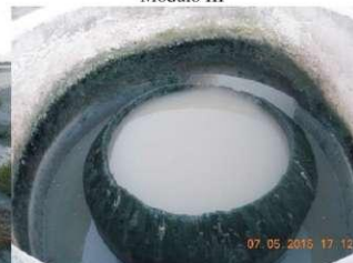
Figura 195 - Dissipador de energia do Módulo III
