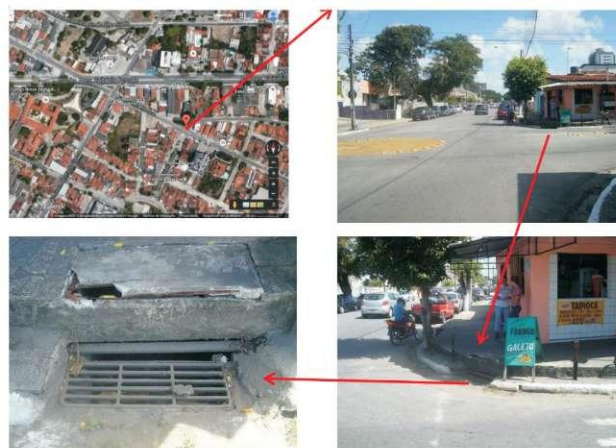
Figura 277 - Problemas de alagamentos no cruzamento da Av. Juarez Távora com o início da Av. Júlia Freire, Torre, João Pessoa, PB.
