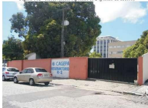
Figura 112 - Reservatório Apoiado R-2 (portão de acesso)
