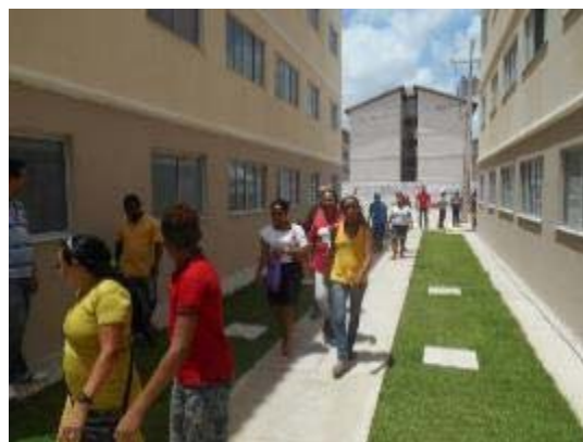
Foto 28 Vistoria de áreas comuns do CH Vista Alegre
