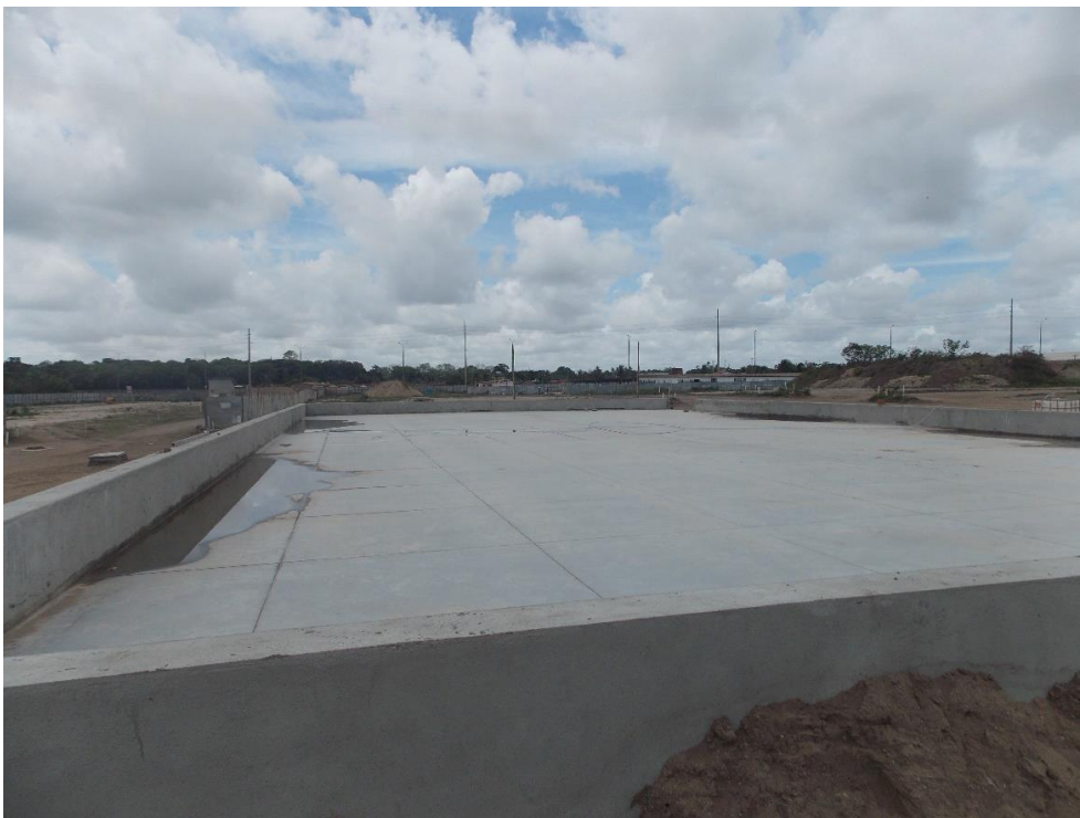
Foto 43 – Implantação de equipamento de saúde de no Residencial Colinas de Gramame
