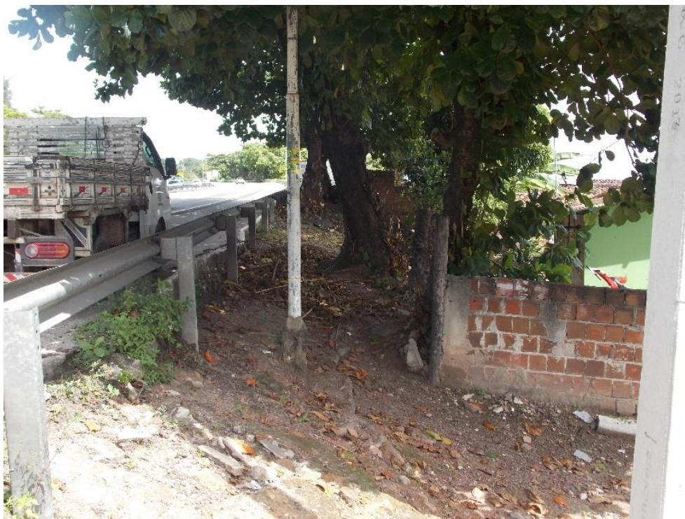
Foto 16 – Casa localizada no talude da rodovia
