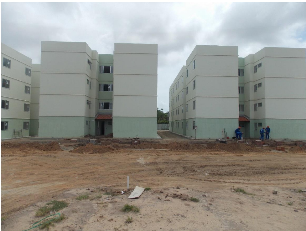
Foto 40 – Vista das Unidades Habitacionais Residencial Colinas de Gramame
