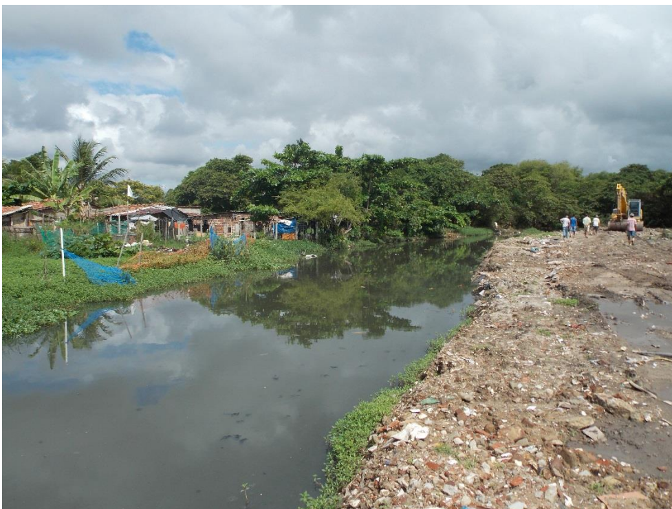
Foto 34 – Vista de afluente (sem denominação) da margem direita do rio das Bombas. Observa-se o avanço do aterramento na área do mangue e ocupação das áreas de APP
