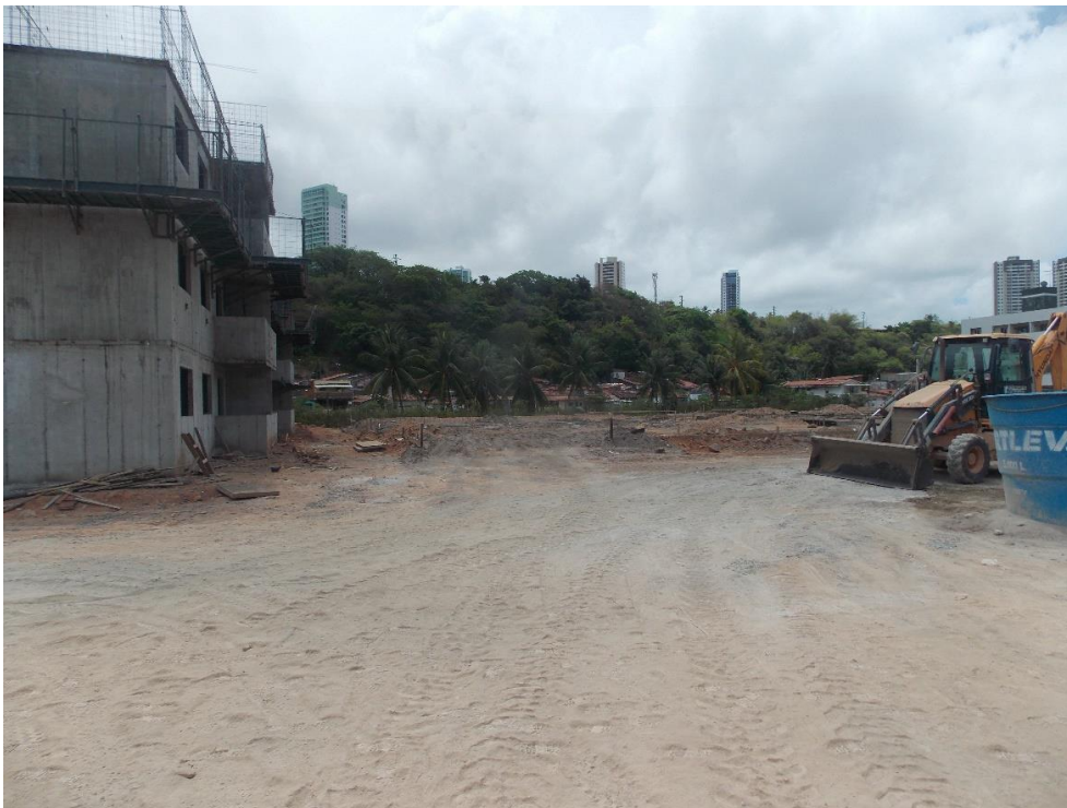
Foto 54 – Vista da Área de Implantação do Residencial Novo São José
