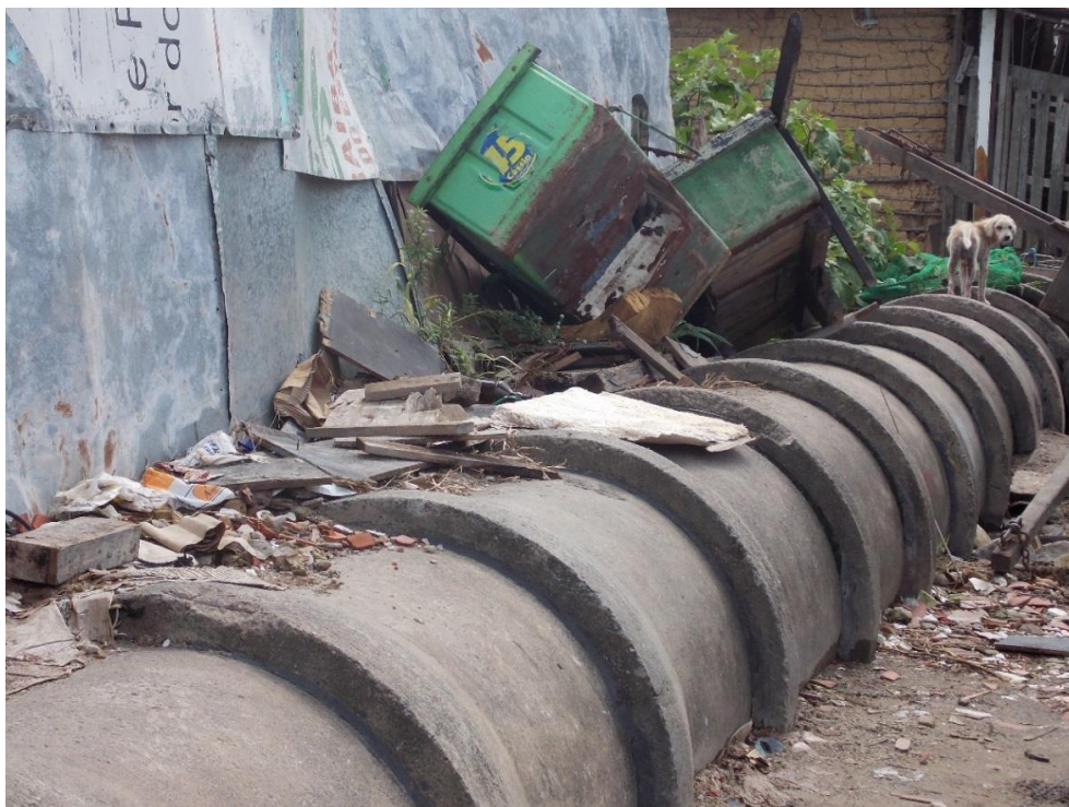
Foto 8 – Vista de coletor tronco de esgoto no Complexo Linha Férrea
