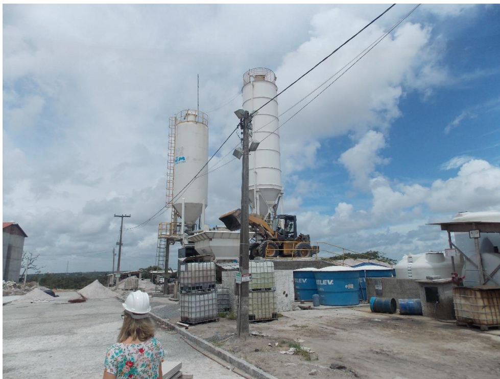
Foto 50 – Obras de Infraestrutura no Residencial Vista Alegre
