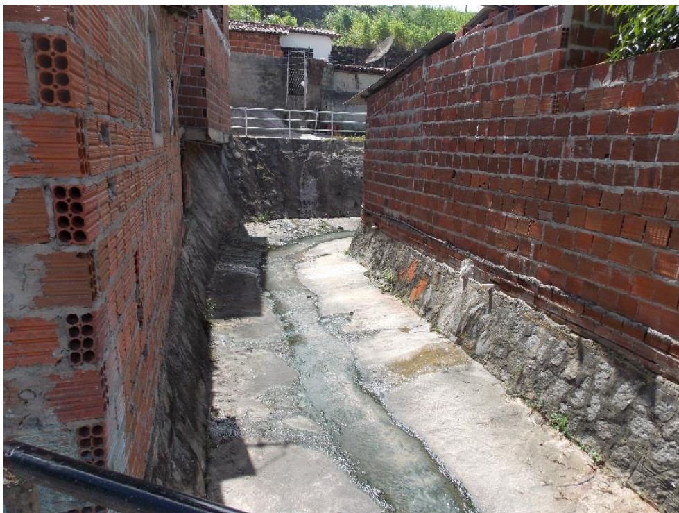
Foto 11 – Esgoto passando por viela do assentamento
