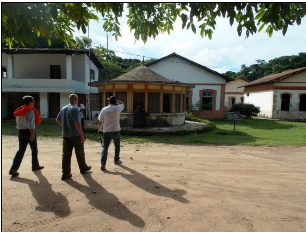
Foto 24 – Vista geral do Poço Amazonas, único ainda em funcionamento
