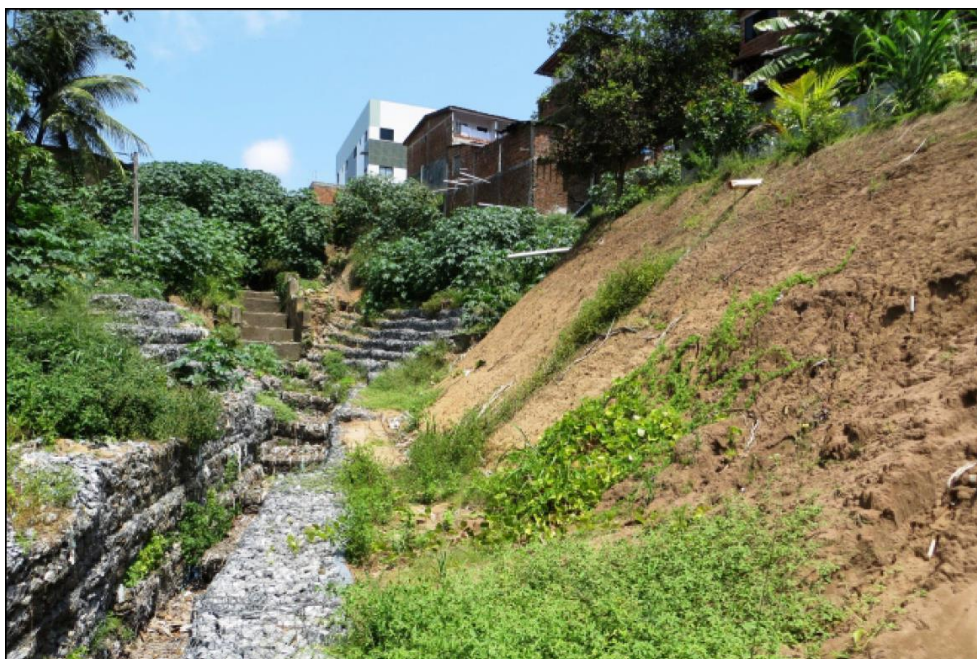
Foto 27 – Vista de taludes e muros de gabião na AR-BR02
