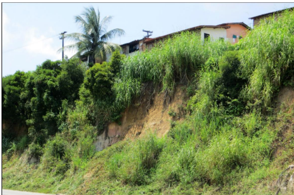
Foto 26 – Vista de talude existente no local e residências em seu topo
