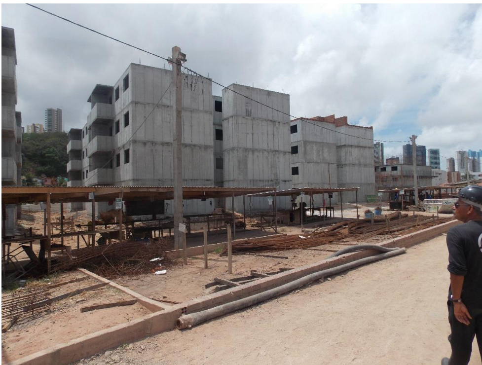
Foto 52 – Vista das Unidades Habitacionais em construção no Residencial Novo São José
