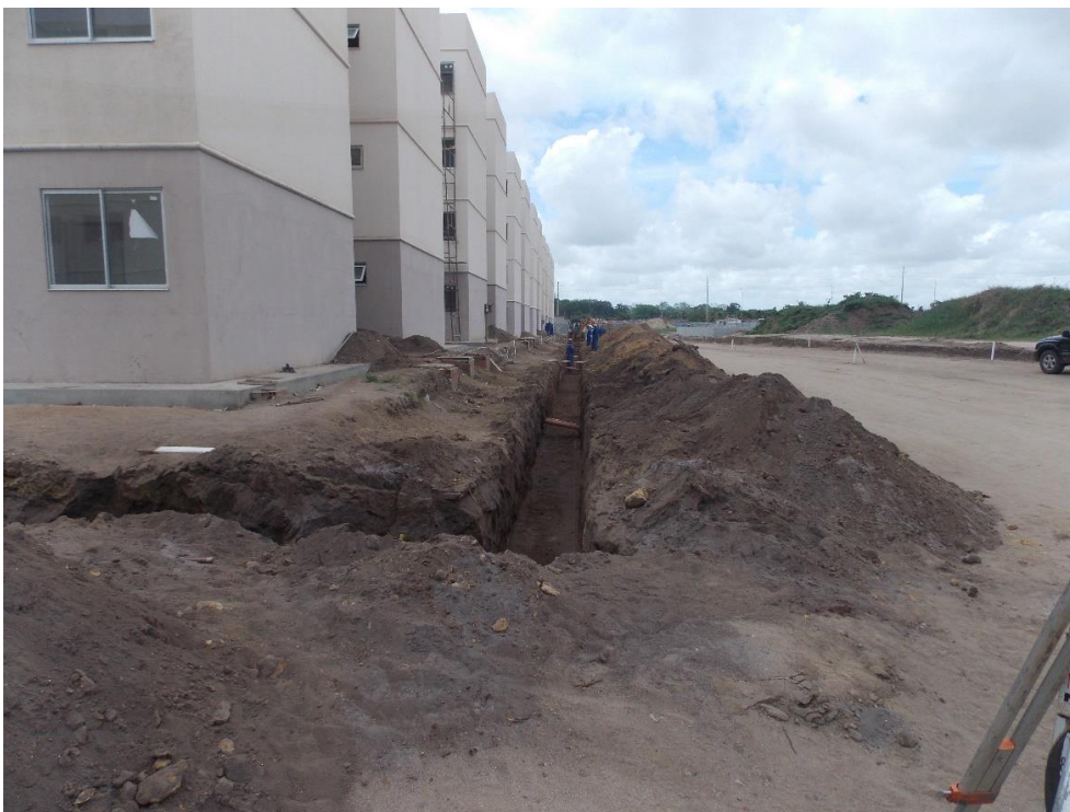
Foto 42 – Obras de Infraestrutura no Residencial Colinas de Gramame
