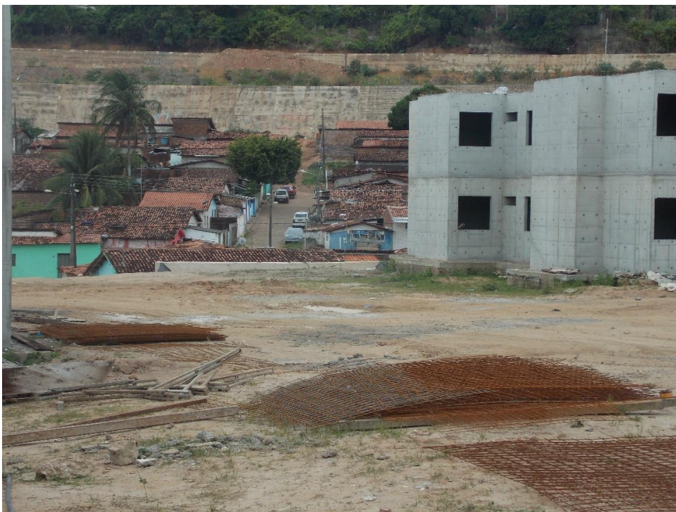
Foto 44 – Vista da Área de Implantação do Residencial Saturnino de Brito
