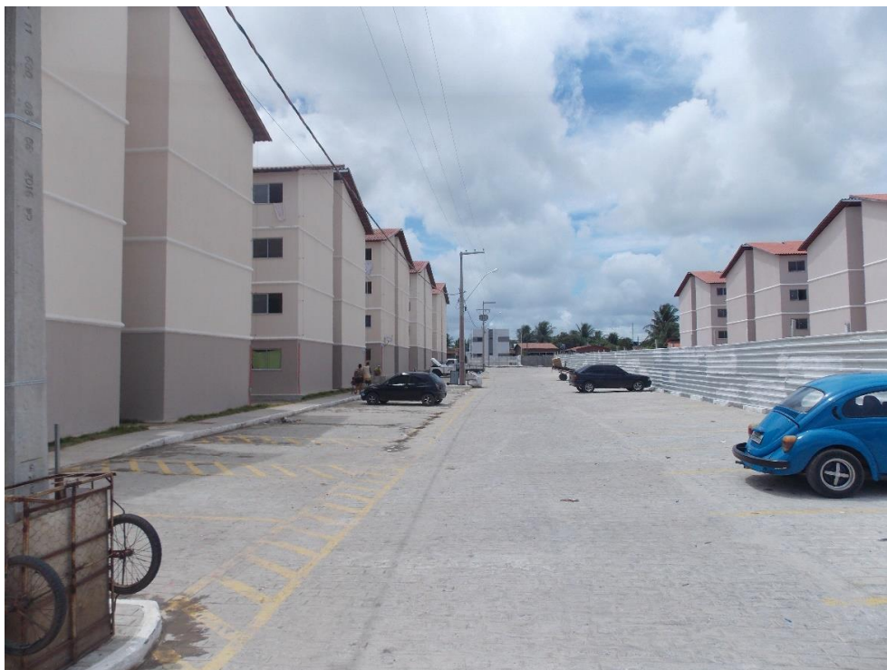
Foto 48 – Vista das Unidades Habitacionais já entregues no Residencial Vista Alegre
