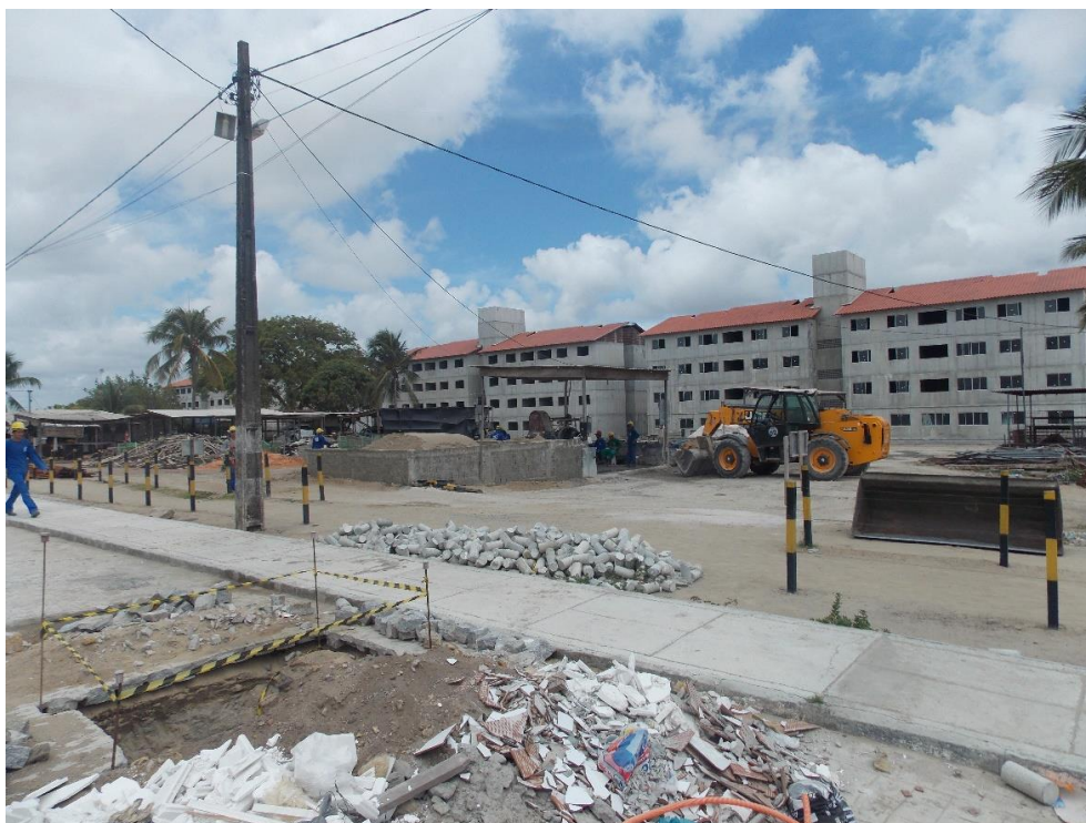
Foto 49 – Vista das Unidades Habitacionais em construção no Residencial Vista Alegre
