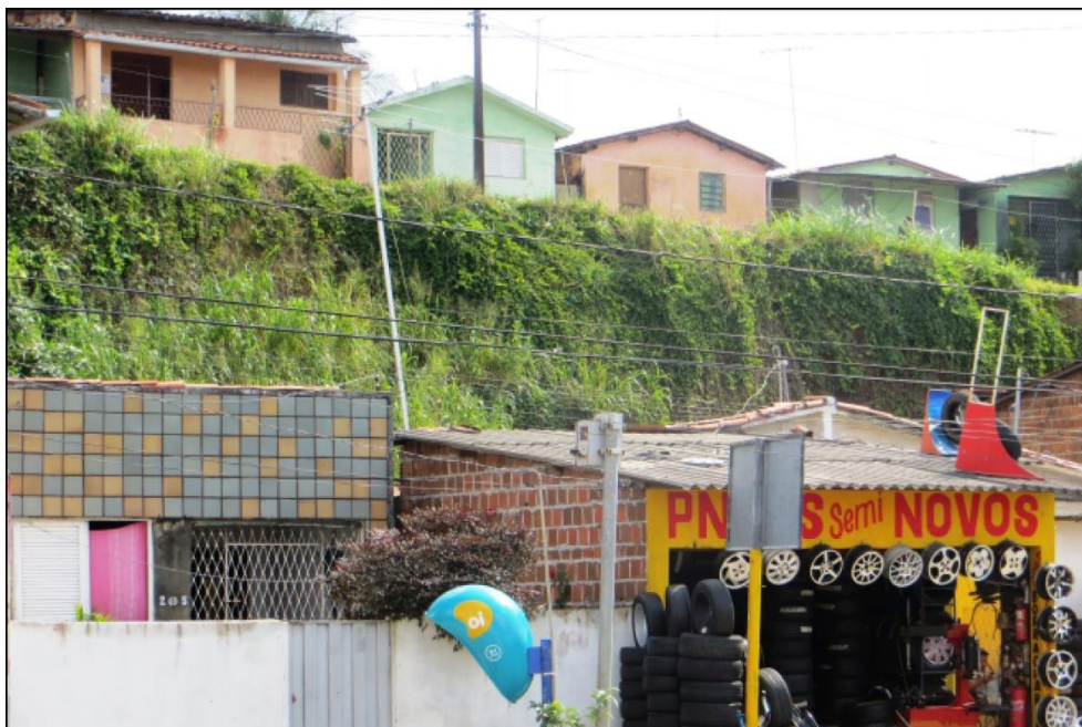
Foto 29 – Vista de encosta, com cerca de 10 metros e residências em seu topo
